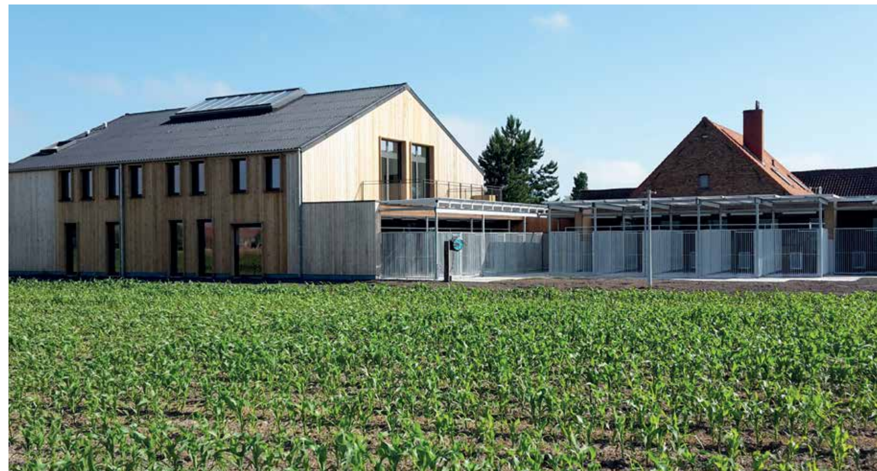
Het multifunctionele gebouw is gekoppeld aan dertien nieuwe kennels.
