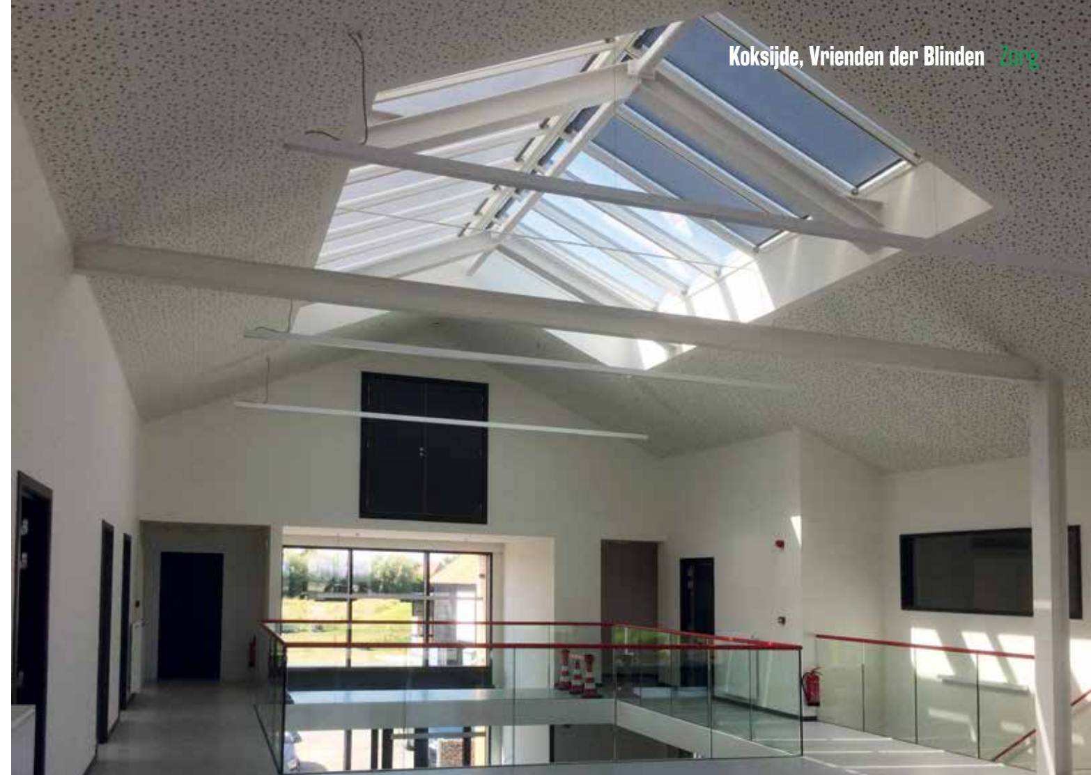
Een slanke glasconstructie in plaats van klassieke balustrades: dat is de stijlvolle valbeveiliging in het nieuwe opleidingscentrum van Vrienden der Blinden.
