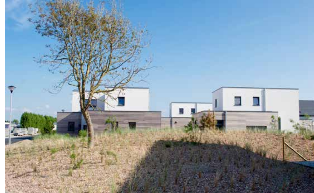
Dankzij traditioneel metselwerk met gevelbekleding in witte crepi en padoek passen de woningen mooi in het landschap.
